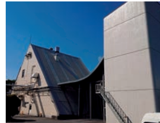
天竜工場（蛋白棟）※耐震補強及び屋根改修工事を行いました。
